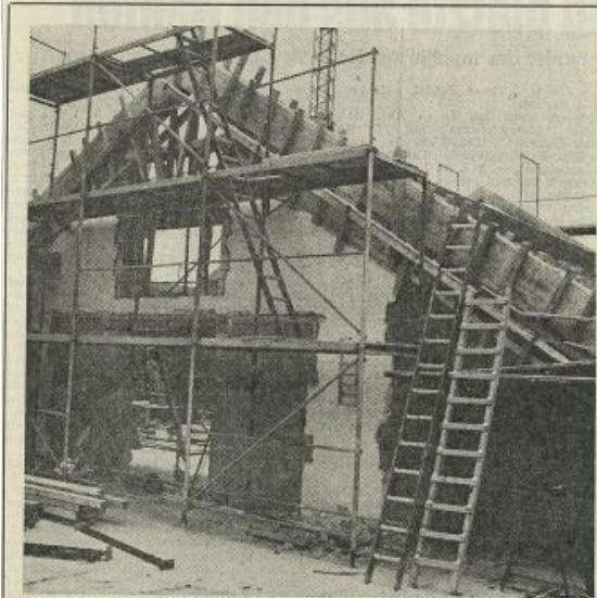
DIE ARBEITEN am Erweiterungsbau der Friedhofskapelle in Nieder-Olm sind voll im Gange. Bis zum Sommer soll die Maßnahme abgeschlossen sein. In der jüngsten Ortsgemeinderatsitzung wurden weitere Arbeiten in Höhe von insgesamt 67 000 Mark vergeben. Mit diesem Geld können nun die Dachböcker-, Zimmerer-, Spengler- und Installationsarbeiten durchgeführt werden. Bereits im Haushaltsjahr 1980 waren im Gemeindefest 50 000 Mark zur Verfügung gestellt worden. Im laufenden Haushaltsjahr sind nochmals 285 000 Mark eingepflicht, die über eine Darlehensaufnahme finanziert werden. Bild: PK'S
