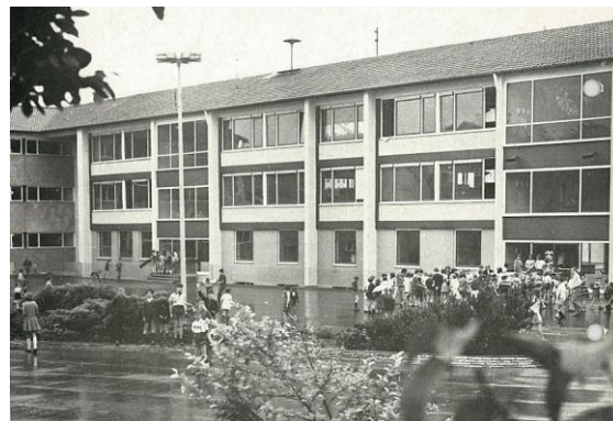
1969, Ostfassade der Grundschule mit Schulhof. 192
