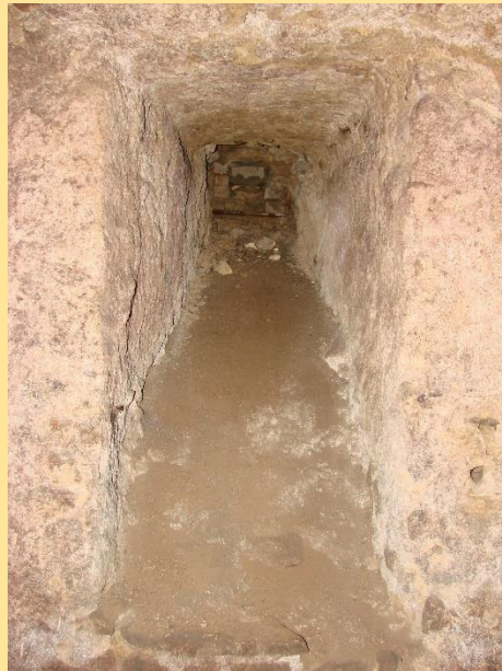
Erhalten gebliebene Kellerwand des alten Rathauses im angrenzenden Anwesen Pariser Straße 97
