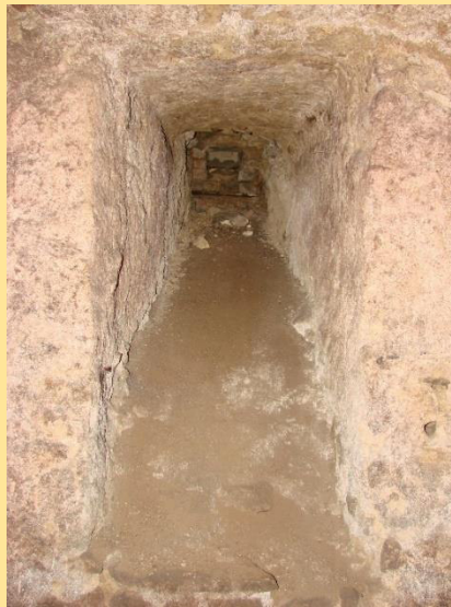
Erhalten gebliebene Kelleraußenwand des alten Rathauses im Anwesen Pariser Straße 97.
